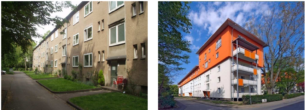
Abbildung 5: Bestandsgebäude und Objekt nach Sanierung und Aufstockung im Vergleich. 20
